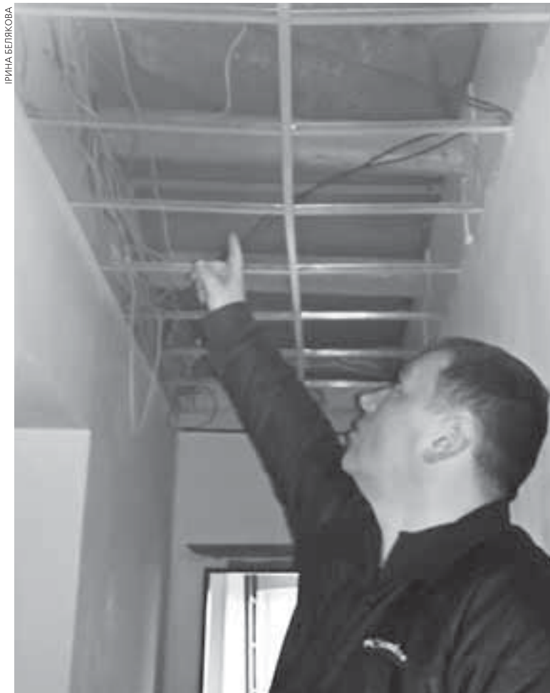
— Вже майже рік минув після ремонту, а у деяких місцях дах досі мокрий, — каже Ігор Шушкевич (38 р.). — Частина приміщень ми відновили власним коштом
