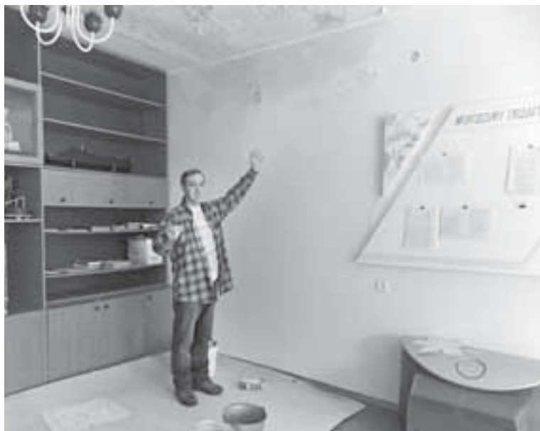
Чиновники рахують, чи вигідно відкривати садок на базі СЮТ. Тим часом приміщення вже давно потребує капітального ремонту
