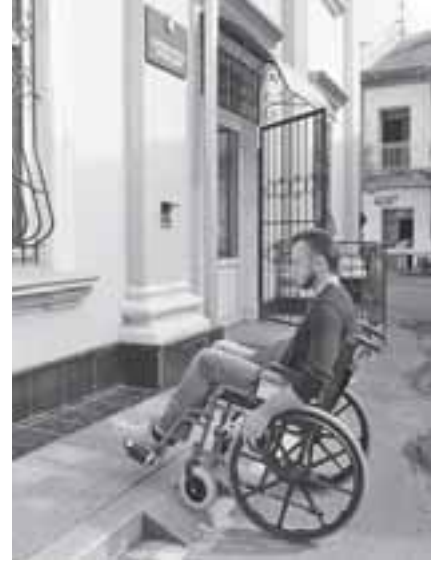
Пандус біля будівлі обласної прокуратури. На нього годі заїхати
