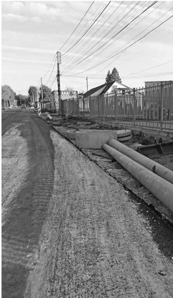
Вздовж дороги прокладають комунікації
